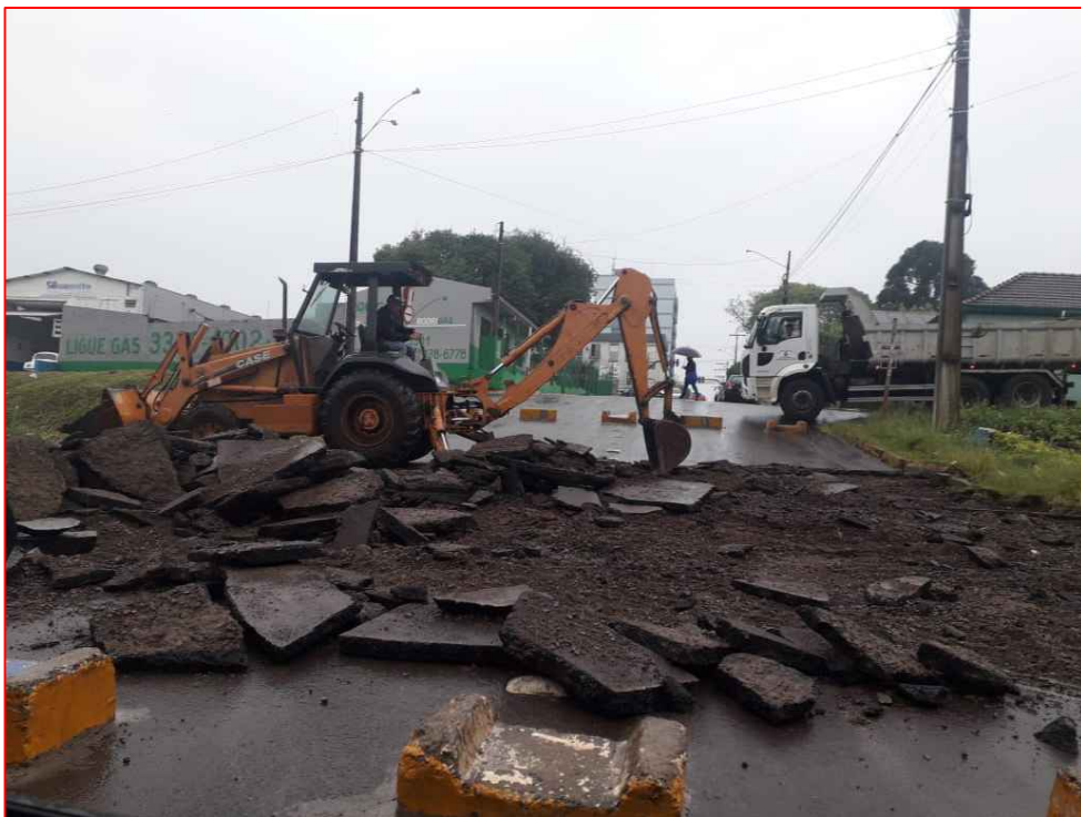
Demolição de Pavimentação Asfáltica
