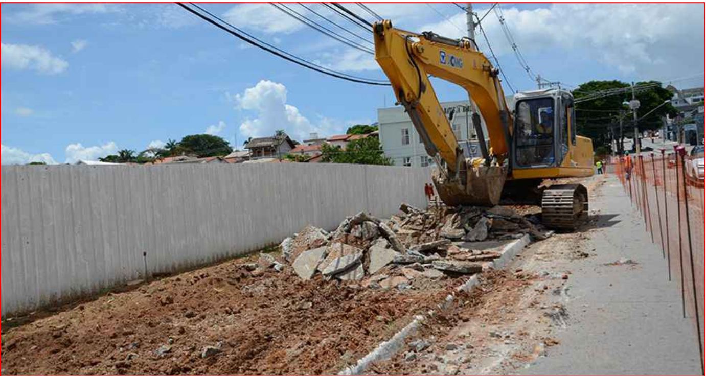
Remoção de Pavimento Intertravado "Paver"
